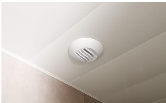
Boca de extracción en baño
