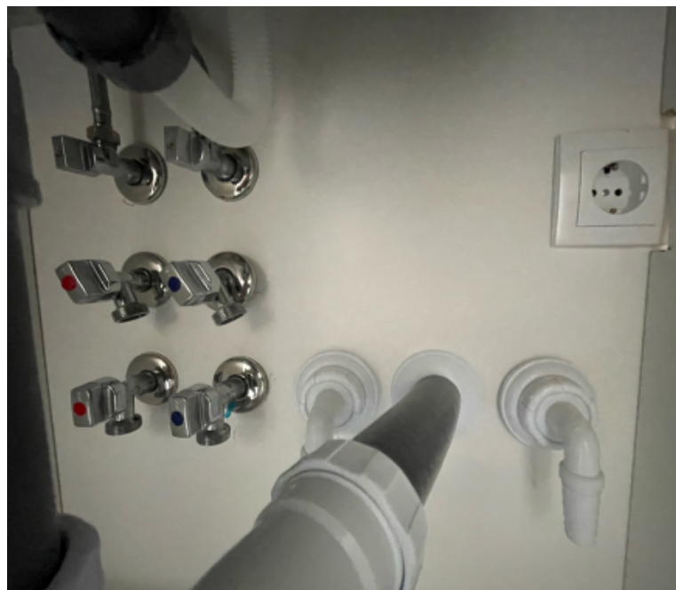
Saneamiento bajo fregadero, tomas de agua para fregadero y lavavajillas
