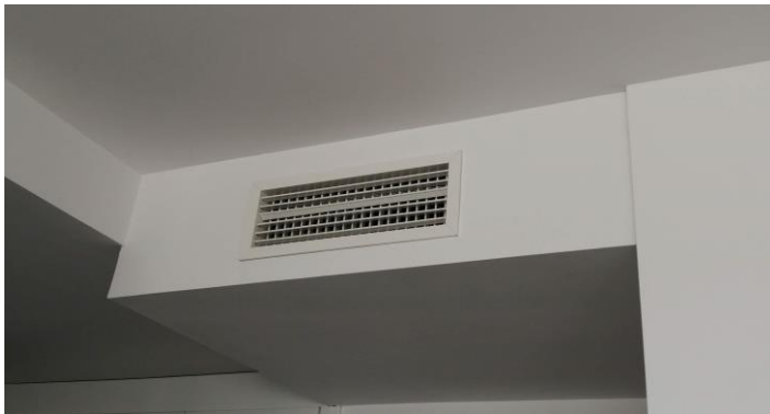
Rejilla vertical de climatización- impulsión
