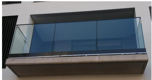
Barandilla de vidrio voladas planta primera
