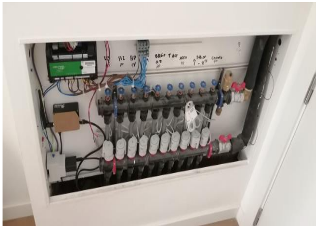
Interior de colector de suelo radiante
