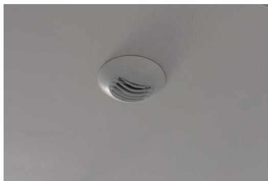
Boca de extracción en cocina
